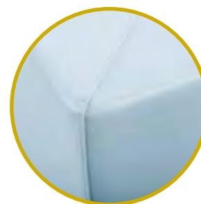
Particolare della cucitura sulla struttura della piscina
